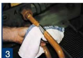
Rohr reinigen
