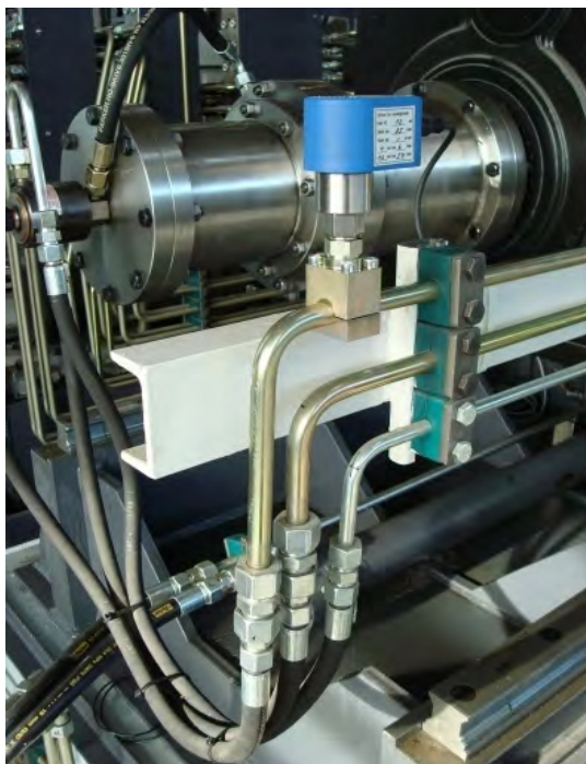
Abbildung 3: Leckagesensor mit Serv-Clip ® -2 zur Erkennung von Dichtungsschäden am Spreitzzylinder einer Haspelmaschine
